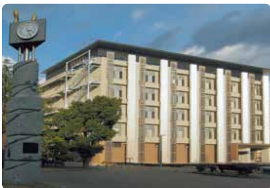
静岡大学 光創起イノベーション研究拠点棟
